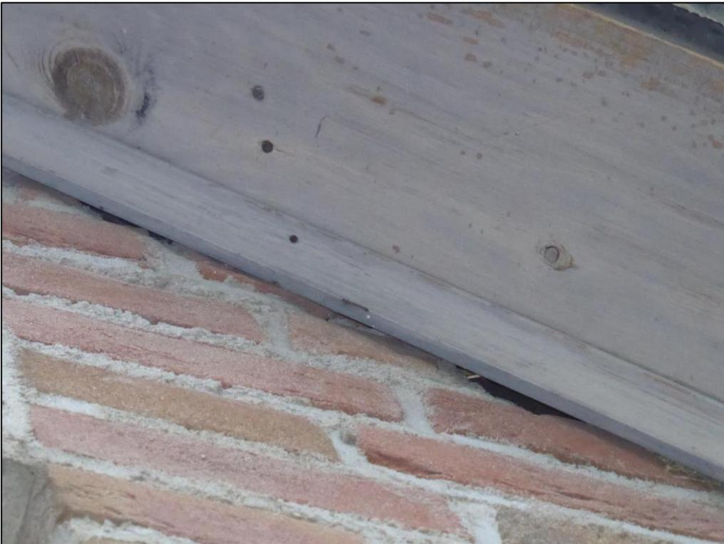
**Abb. 8: Offene Fugen an der Giebelseite (Ortgang)**
