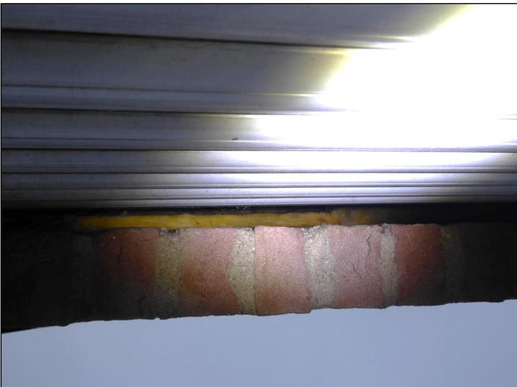
**Abb. 9: Blick in die Dämmung zwischen Klinker und Mauerwerk**
